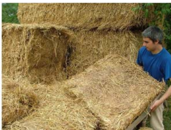
Obr.: Veľké balíky obsahujú vrstvy hrubé jeden decimeter, tie sa pohodlne odlupujú a vkladajú do konštrukcie tvorenej „rebríkmi“ z dosiek prepojených kúskami OSB dosák ako priečkami. Pre zrýchlenie práce a dosiahnutie dokonalého vyplnenia dutiny je vhodné úseky medzi „priečkami rebríka“ vyplniť tenkými tabuľami EPS. Poslednú kartónovú vrstvu možno postupne odspodu pripevňovať už počas vkladania slamených vrstiev. Rozostup „rebríkov“ je zhodná so šírkou veľkých slamených balíkov.
