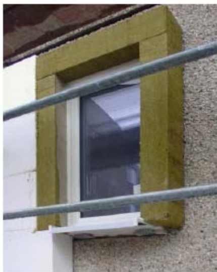
Obr.: Príklad kombinovania EPS s minerálnou vatou v okolí okna (zdroj: „ARDP“).
