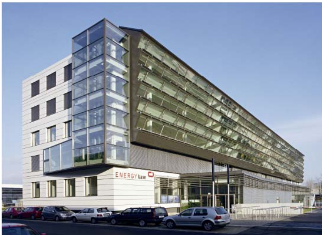
Obr.: Budova EnergyBase má južné okná sklonené nadol, nad nimi sú naopak dobre oslnené FV panely
