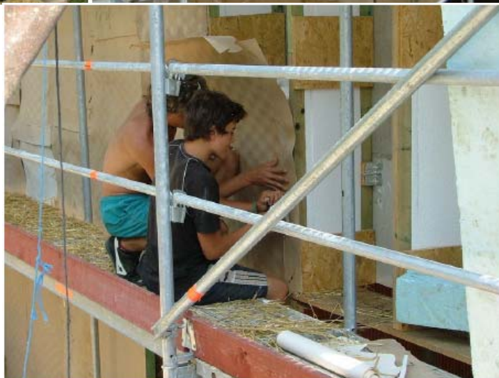
Obr.: Veľké balíky obsahujú vrstvy hrubé jeden decimeter, tie sa pohodlne odlupujú a vkladajú do konštrukcie tvorenej „rebríkmi“ z dosiek prepojených kúskami OSB dosák ako priečkami. Pre zrýchlenie práce a dosiahnutie dokonalého vyplnenia dutiny je vhodné úseky medzi „priečkami rebríka“ vyplniť tenkými tabuľami EPS. Poslednú kartónovú vrstvu možno postupne odspodu pripevňovať už počas vkladania slamených vrstiev. Rozostup „rebríkov“ je zhodná so šírkou veľkých slamených balíkov.
